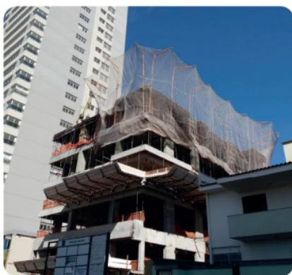
O **MMA SLQA (Sistema Limitador de Queda e Altura)**, conhecido como EPC, é projetado para prevenir quedas de pessoas e objetos, especialmente nas áreas mais críticas. O sistema é ajustável de acordo com a estrutura da edificação, envolvendo-a com uma rede que cobre todo o perímetro dos três pavimentos superiores.
