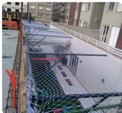
A **MMA Telas Especiais** oferece um sistema projetado para garantir a segurança de transeuntes e edificações próximas. Instalado verticalmente por meio de suportes e redes, previne completamente a queda de ferramentas e outros detritos durante a execução.
